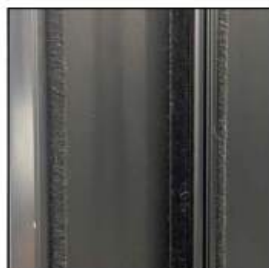
Door Pile Weatherstrip Applied on the Door Jamb.
